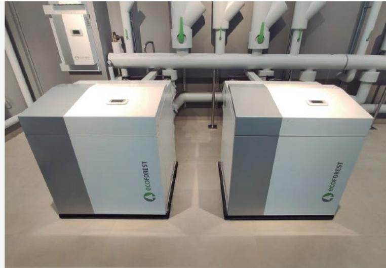
Además, el e-source activa y desactiva las fuentes en función de la demanda térmica del edificio, priorizando la primera fuente y activando o desactivando las otras dos según sea necesario.
